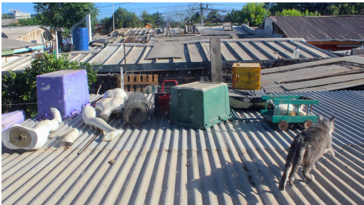
Figura 12. Amigo. A. (2021) Techo [Fotografía]. Archivo personal
